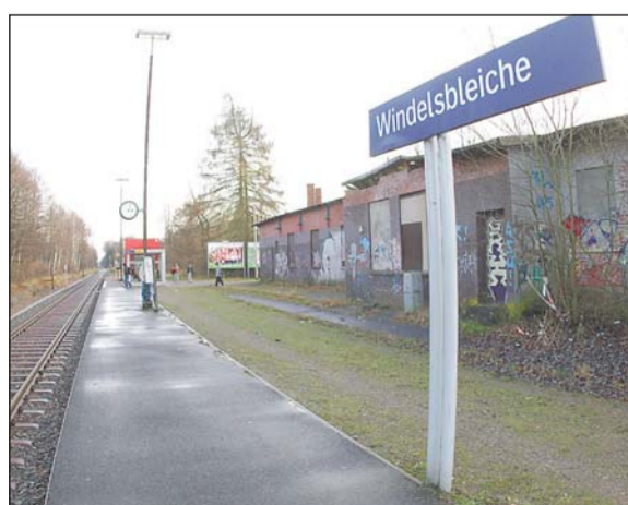
Das marode Bahnhofsgebäude in Windelsbleiche ist vielen Sennern ein Dorn im Auge. Nach dem Willen der CDU könnte hier ein Einkaufszentrum entstehen.
